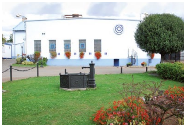
slévárna po rekonstrukci
