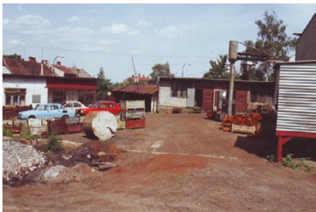
slévárna před rekonstrukcí
